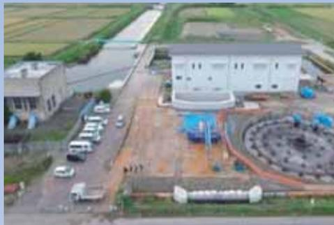
機場上屋が完成。用水吐出し水槽底盤を打設中。
