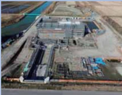
樋管・排水吐出し水槽を建設中。建屋の建設も進んでいます。
