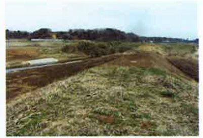
岩戸集水路復旧事業完了
