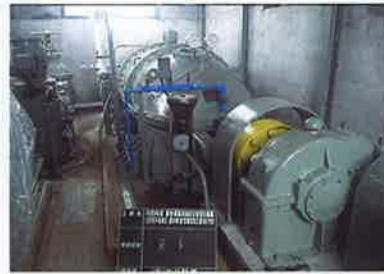
臼井第二機場復旧事業完了
