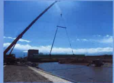
吉高幹線水路【水管橋】建設工事
