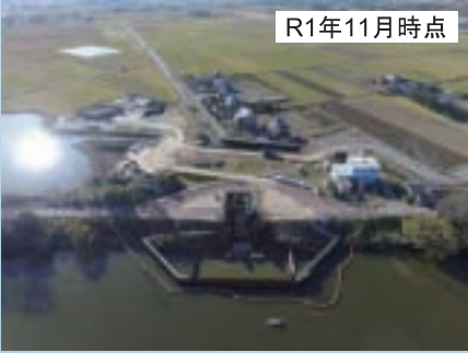
樋門建設状況
